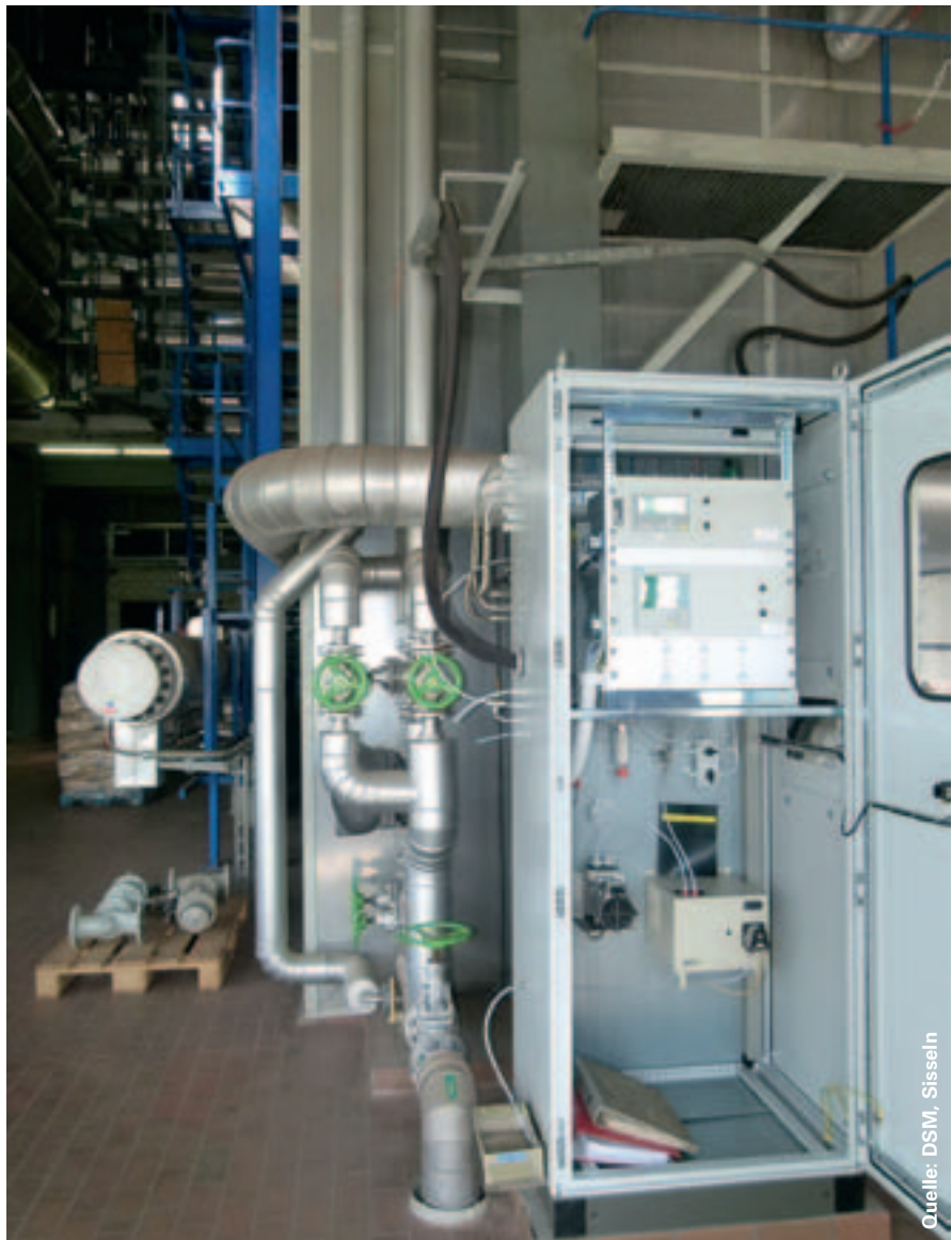
Im Vordergrund die Messgeräte der kontinuierlichen Emissionsmessstelle (Sauerstoff und Kohlenmonoxid) an einem grossen Dampfkessel
